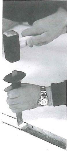
Har du valgt en termostat med gulvsensor, må det hugges/freeses et spor som er tilstrekkelig bredt til begge el-rørene (Strøm- og sensorkabel i hvert sitt rør).
