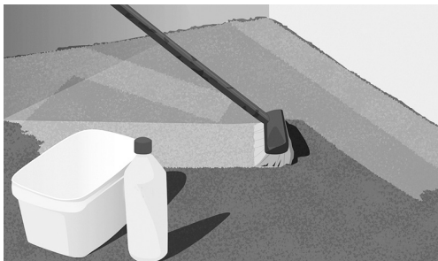
Kuva 7. Puhdista ja esikäsittele lattia.
