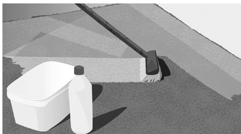
Fig. 7. Rengør og forbehandl gulvet.
