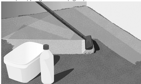
Fig. 7. Så rengjør og forbehandler du gulvet.
