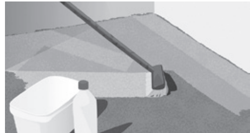
Abb.3 Boden reinigen und grundieren
