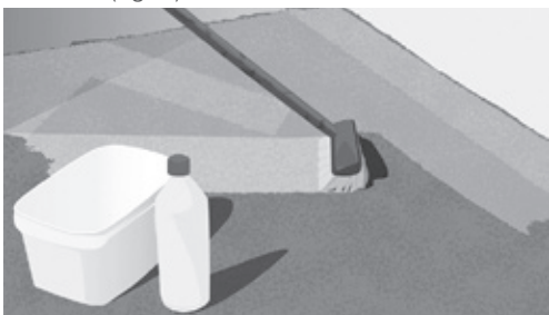
Fig. 3. Rengør og forbehandl gulvet
