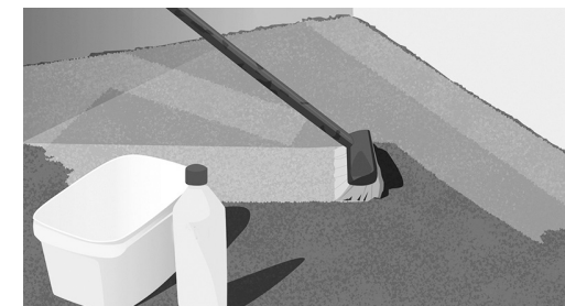
Fig. 4. Rengjør og påfør primer på gulvet
